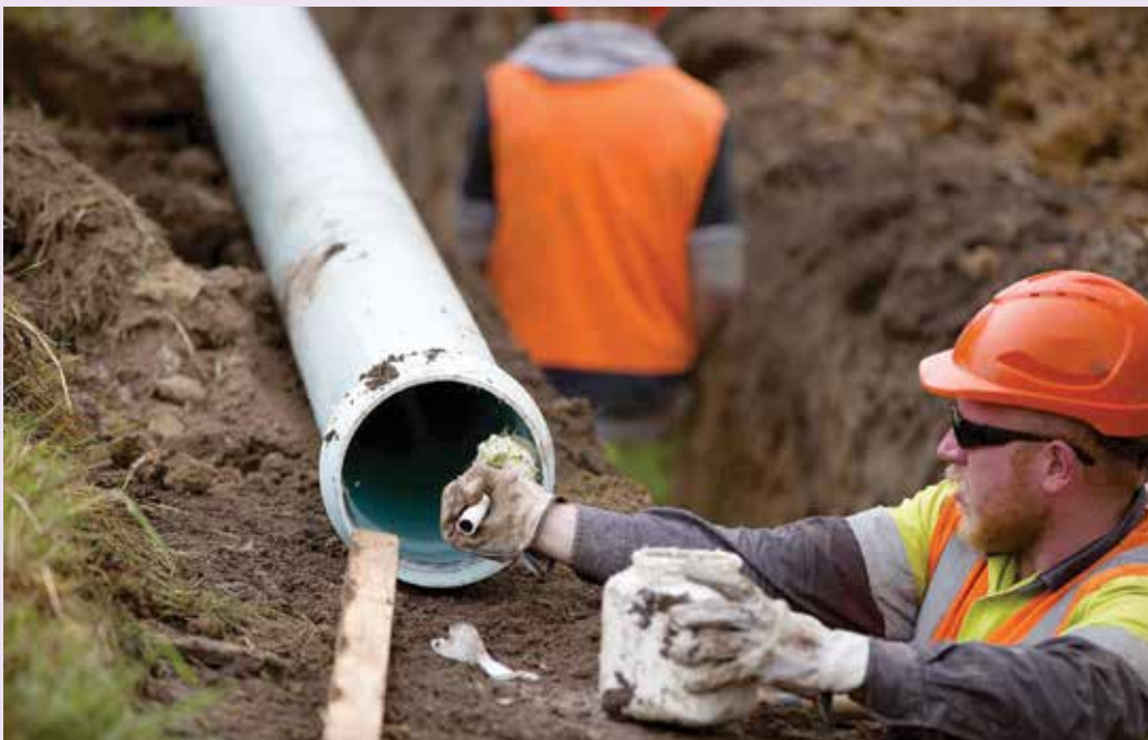
پروژه ۳۴ کیلومتری نیوزیلند طولانی‌ترین خط انتقال آب با لوله‌های OPVC
